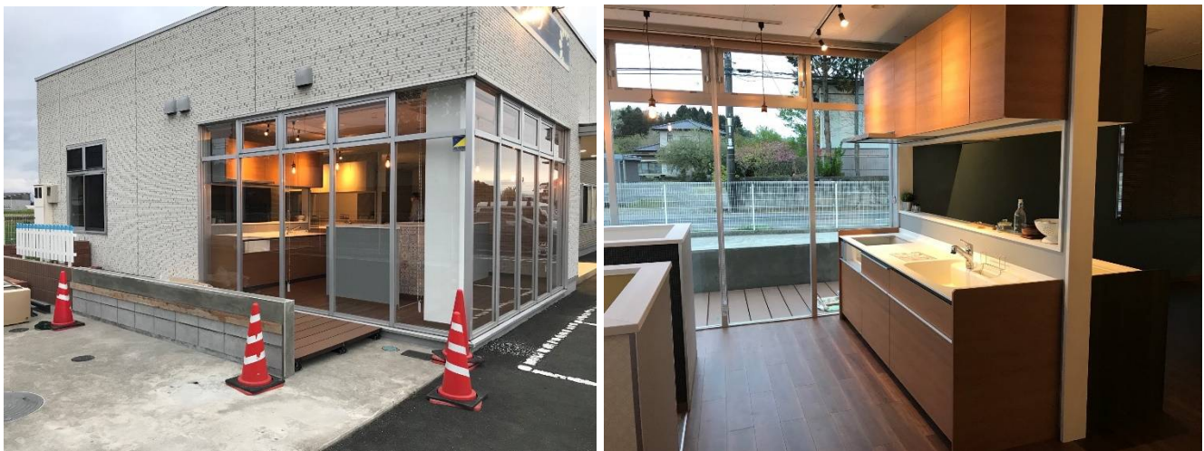
改装中の新店舗（水回り専門「大田原ショールーム店」・リテール&卸売「大田原店」）とショールーム一部
